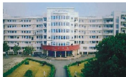
河西校区教学大楼
